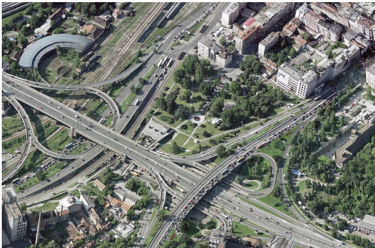
Slika 26. Mostarska petlja, neposredno pre skidanja železničkih koloseka, 2017. godina https://i.pinimg.com/originals/6b/d8/ca/6bd8cab9a6bfa837005c2b2e2bbf798b.jpg
