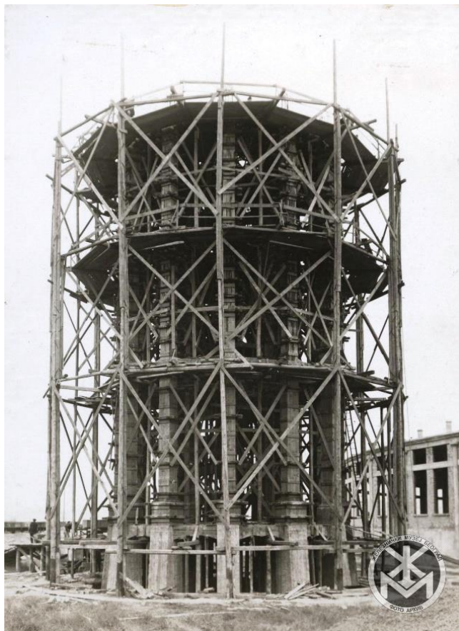
Slika 19. Izgradnja vodotoranja, 1925.godine. Muzej Železnice.
