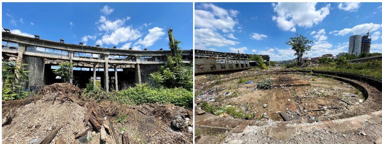
Slika 33. i 34. Postojeće stanje kompleksa Ložionice i Okretnice
