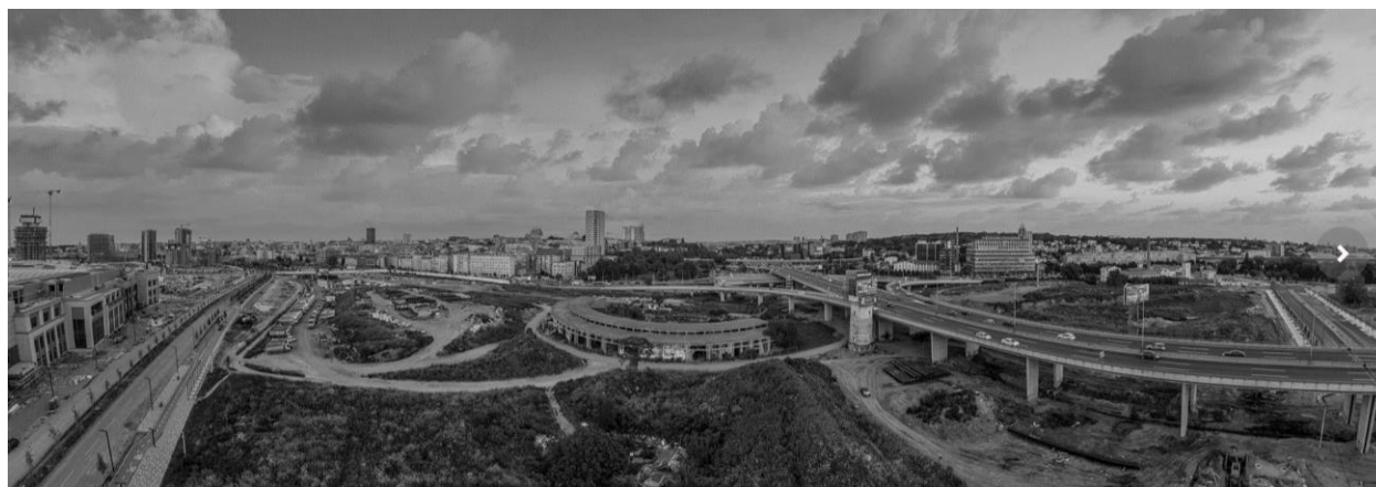
Slika 38. Pogled na prostor Ložionice
