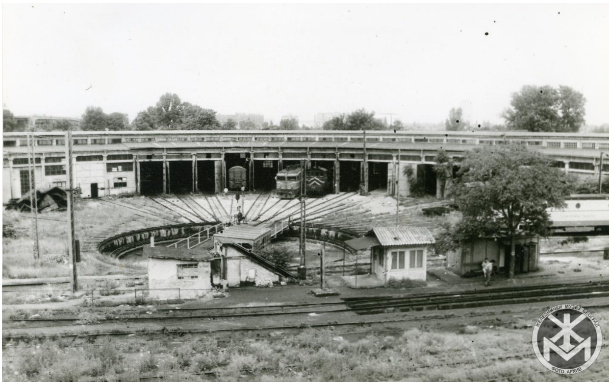
Slika 16. Pogled na centralni deo polukružne hale Ložionice Beograd – Kompleks železničke stanice Beograd (snimio G.Matijević, juna 1995.g,F.F.15/95). Muzej Železnice.
