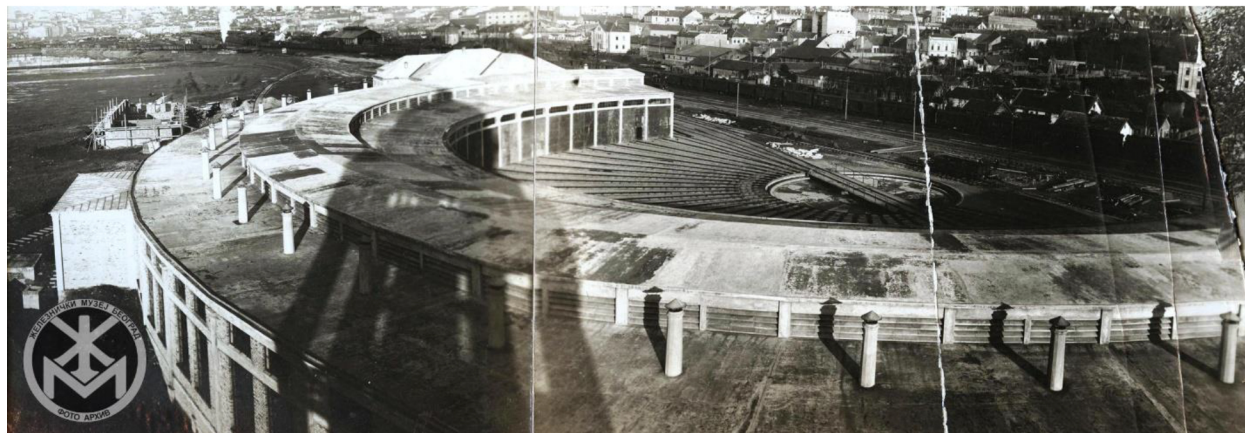
Slika 44. Ložionica, okretnica i vodotoranj; na fotografiji se delimično može videti originalni izgled spoljne severne lučne fasade. Muzej Želznice.
