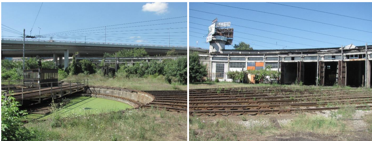
Slika 47. i 48. Okretnica neposredno pre skidanja železničkih koloseka
